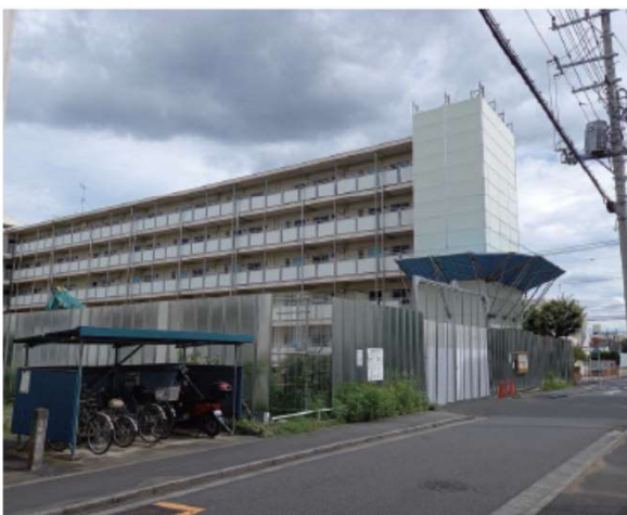
▲鹿浜五丁目アパート。解体工事準備中
