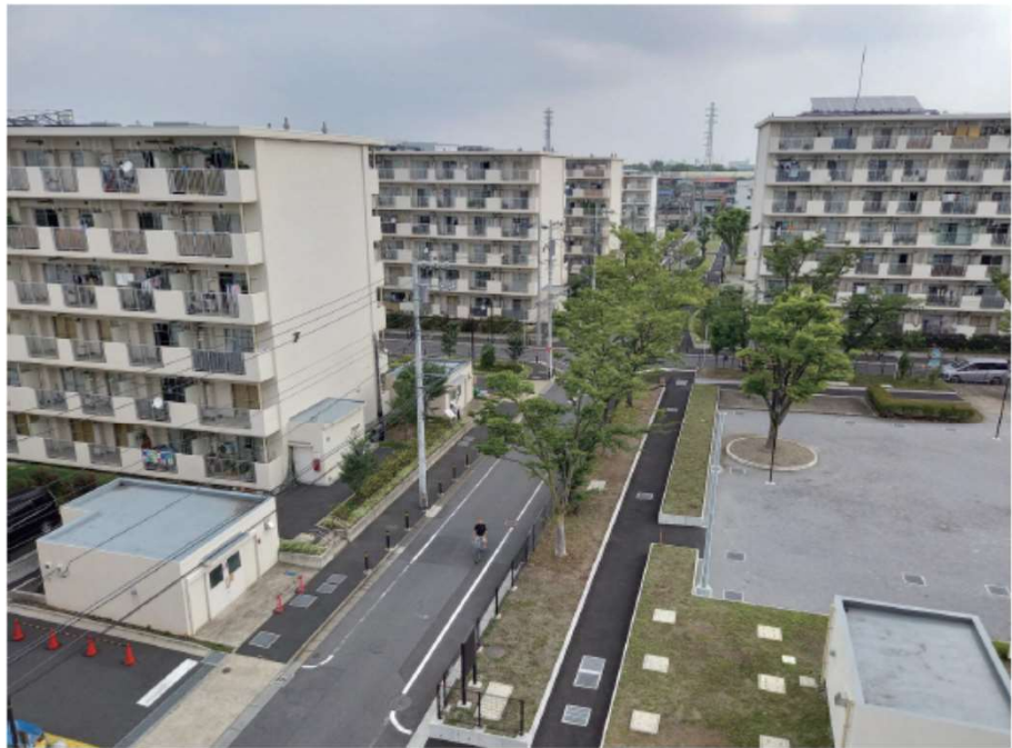
▲建て替えが完了した鹿浜二丁目アパート。公園との緑の配置も美しい
