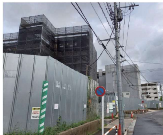
▲上沼田第三アパート建設中
