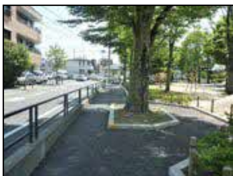
園路の凸凹改修
