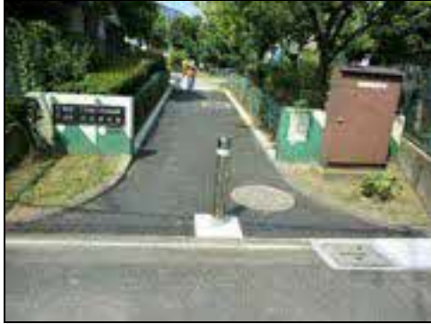
園路の凸凹改修
