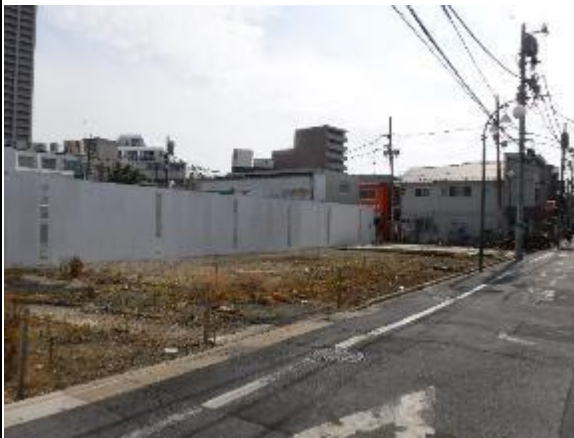
上: 施工前現場写真
