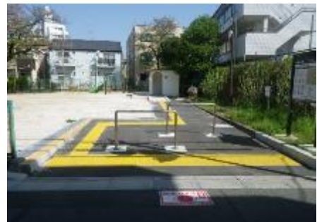
トイレへの誘導・出入口の点字
