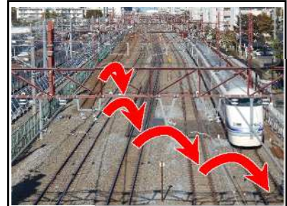
本線の仮移設工事 (東京メトロ車庫付近)
