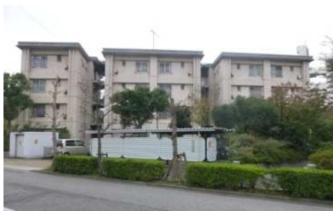
大谷田一丁目第3アパート外壁改修
