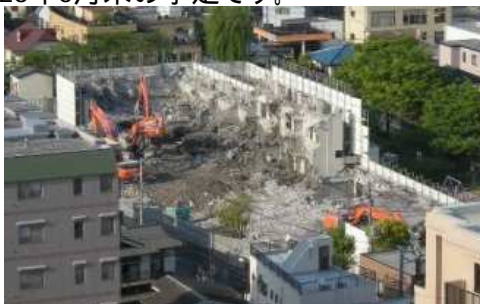
中央本町四丁目アパート解体
