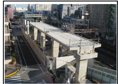
高架橋工事 (エミエルタワー前)
