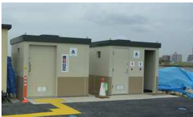
荒川右岸西新井橋緑地トイレ
