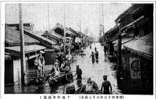
(上) 北千住駅前通り (中) 浸水した線路と蒸気機関車 (北千住) (下) 当館所蔵絵葉書。まったく同じ写真が、今回柳下氏から提供された。
