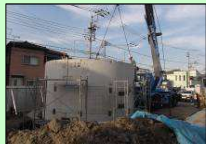
施工中の様子
