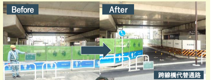
跨線橋代替通路
